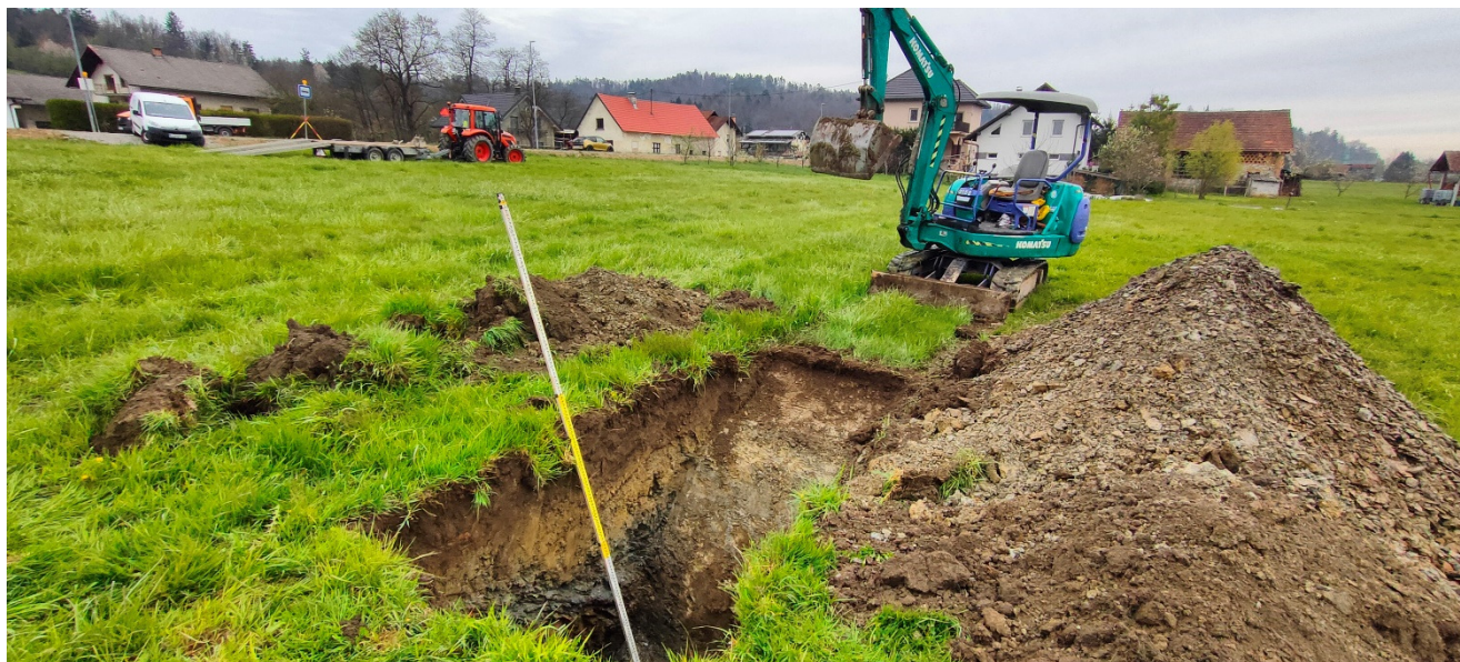
Slika 5: Sondažni razkop S2 v območju parcele 1889/1. Lepo je razvidna rahla nagnjenost pobočja iz regionalne ceste na levi strani fotografije proti AC (ki sicer ni vidna) na desni strani fotografije. V primeru odloženih kvartarnih jezersko barjanskih sedimentov je pričakovati ravno površje. Višinska razlika med južnim robom parcele 1897/17 in koto asfalta regionalne ceste je približno 2-2,5m.
